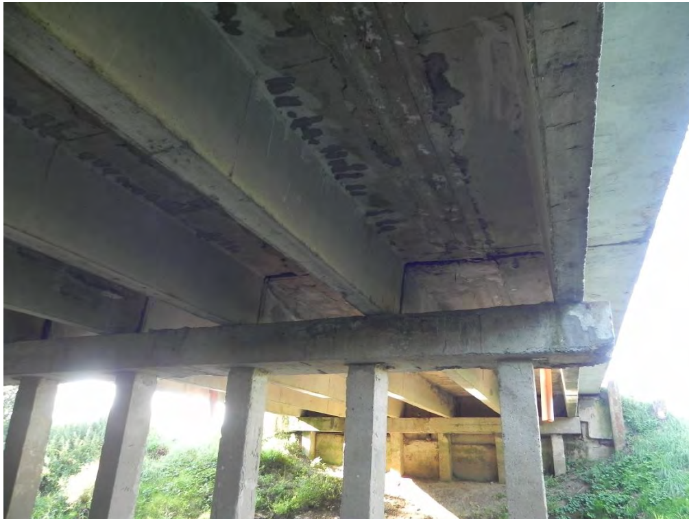
11 pav. Nesandarus deformaciniai pjūviai
