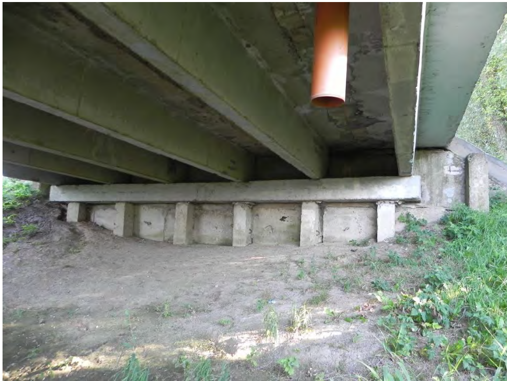
10 pav. Pažeistas hidroizoliacijos sluoksnis, vanduo skverbiasi per perdangos konstrukcijas
