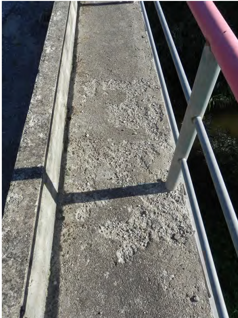
8 pav. Pažeista šalitilčių einamoji danga
