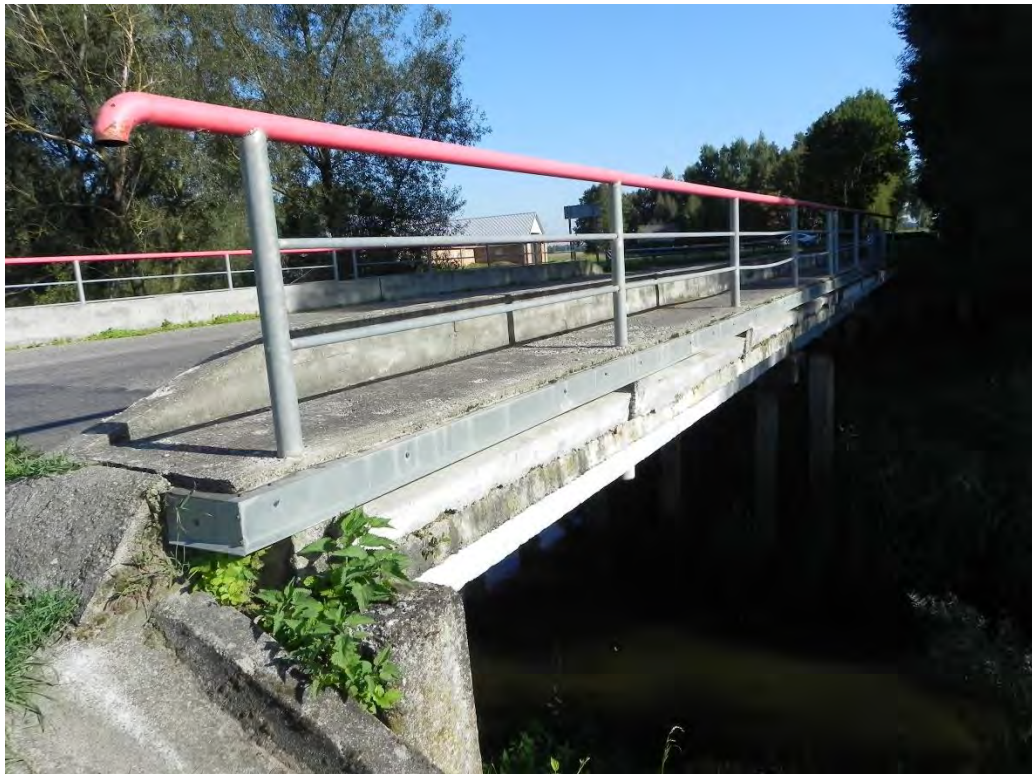
6 pav. Vandens nuvedimo latakai tilto prieigose netvarkingi
