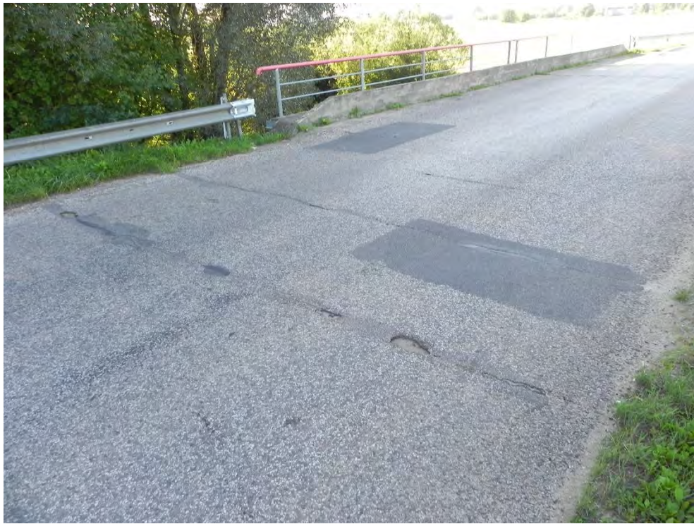
4 pav. Supleišėjusi ir duobėta asfalto danga ant tilto ir prieigose
