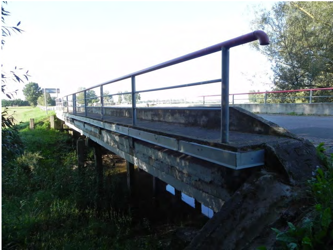
14 pav. Nėra sklandaus suvedimo šalitilčių su tilto prieigom
