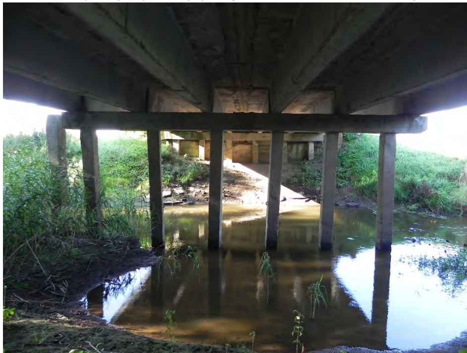
13 pav. Paplauti upės vagos šlaitai ties krantinėmis atramomis
